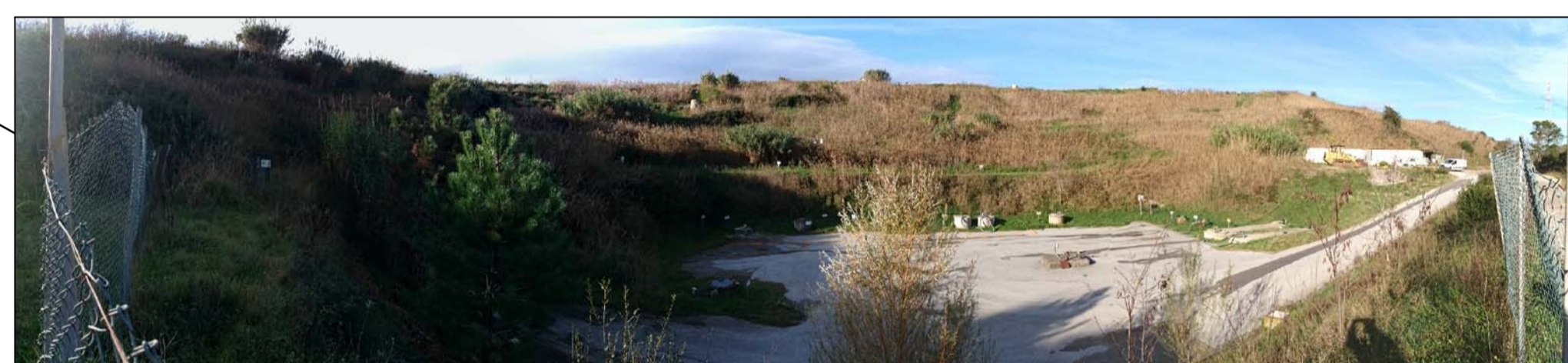
Zona "Anfiteatro". A seguito di lavori di implementazione delle vasche del percolato, lo stato dei luoghi e le reti/sottoservizi potrebbero risultare diversi e dovranno essere verificati dall'Impresa prima dell'inizio dei lavori
