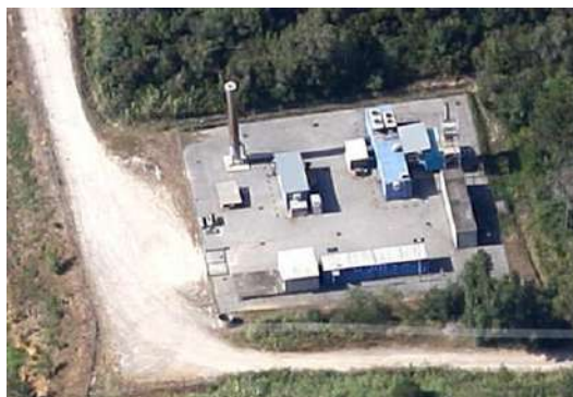
Figura 10 - ex Impianto Biogas - Torcia
