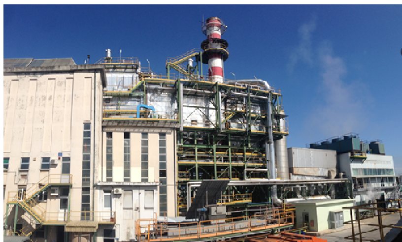
Figura 7- Vista d'insieme del termovalorizzatore
