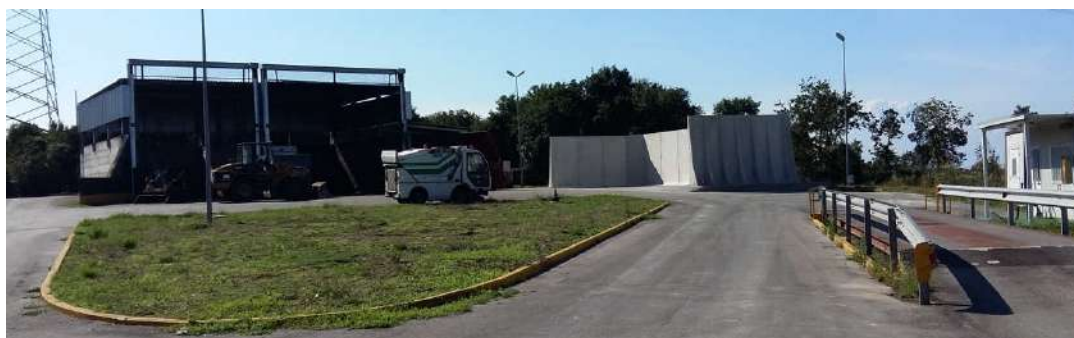
Figura 11 – Impianto stoccaggio rifiuti (organico, sfalci e potature)
