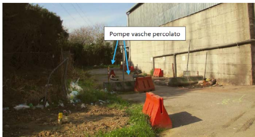
Foto 8 – Sottoservizi zona K-M area stoccaggio organico
