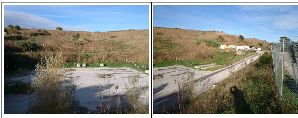
Foto n. 12 – Versante dell'anfiteatro e strada soprastante.
