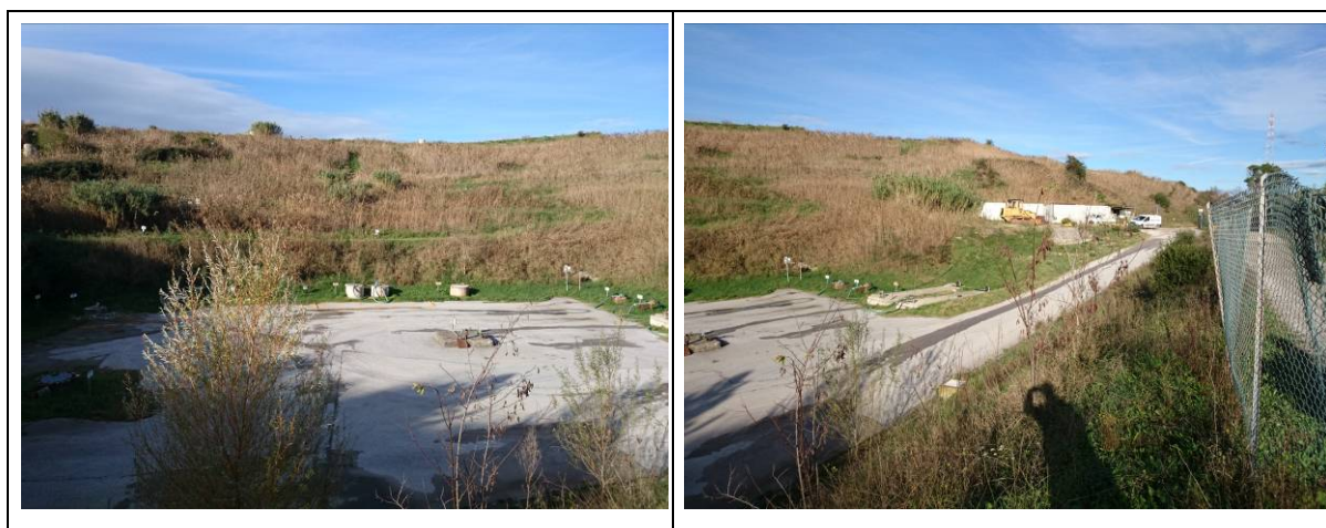
Foto n. 12 - Versante dell'anfiteatro e strada soprastante.
