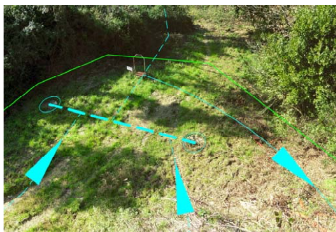
Foto 9 – Sottoservizi zona R-S, trincea drenante terre armate
