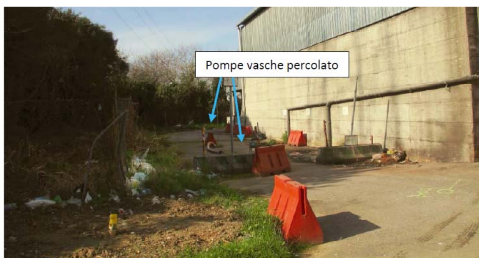
Foto 8 - Sottoservizi zona K-M area stoccaggio organico
