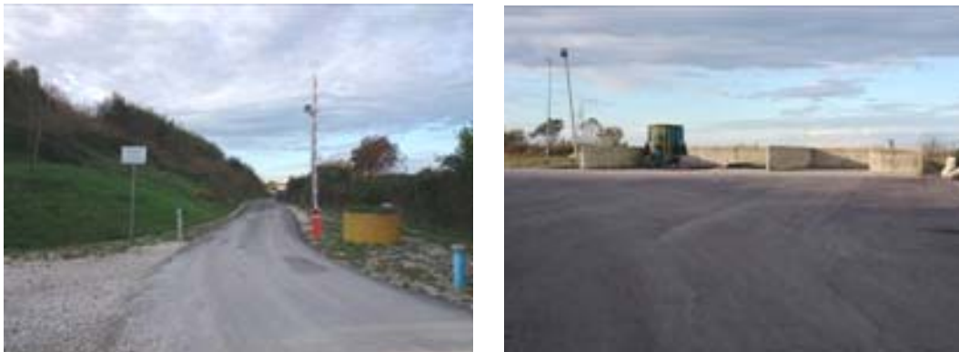
Foto n. 2 – Cannello d'ingresso e vecchie strutture di stoccaggio organico.
